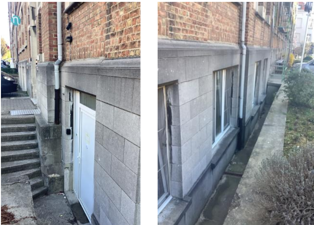
Exemple de surface « Jardin » sur le bâtiment Don Bosco
